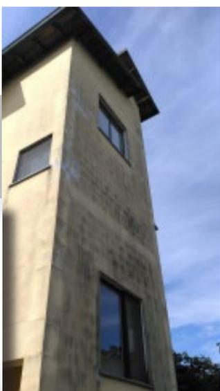
CP0 è un rivestimento di finitura a spessore organico minerale per esterni ed interni ad alta traspirabilità ed idrorepellenza, ha caratteristiche di flessibilità che possono essere migliorate abbinando il rasante CP1 e la rete elastica FLEXONET.
